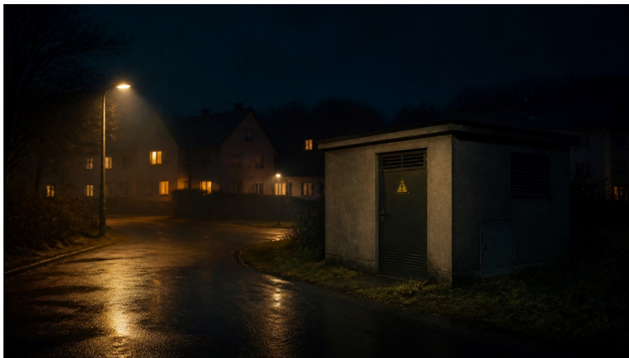
Abb. 2 — Ort des Systemwechsels: die Ortsnetzstation am Rand der Siedlung (Bild: KI-generiert, Canva)
